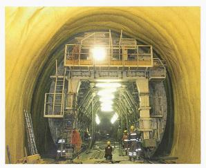
Stahlschalung zum Betonieren eines Gewölbes
