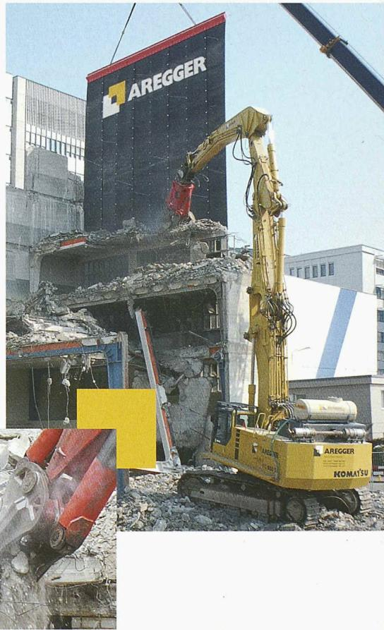
Bis heute war der komplexe Abbruch von Grossobjekten mit Getöse, Staub und Bergen von sperrigen Trümmern verbunden. Das ist jetzt vorbei. Unsere hochmodernen Hydraulikscheren fressen sich scheinbar mühelos und sicher durch jede Stärke und Dimension von Beton und Stahl. Nahezu erschütterungsfrei und mit wenig Lärm, während der schwere Schutzhornung dafür sorgt, dass die Umgebung wirksam geschützt ist.
