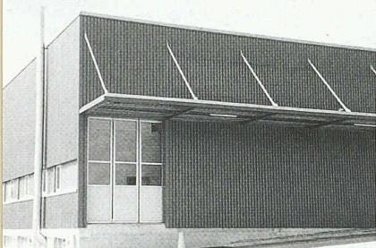
Darwaform-Profilbleche bestehen aus kaltverformtem Stahlblech und sind feuerverzinkt. Dank der Verzinkung ist der Stahlkern beidseitig vor Korrosion geschützt. Der zusätzliche Polyesterlack – erhältlich in umfangreicher Farbpalette – gewährt einen weiteren Schutz gegen Witterungseinflüsse. Die Profilbleche werden für Dacheindeckungen und Fassadenbekleidungen von Industrie- und Gewerbegebäuden, Unterständen sowie für landwirtschaftliche Betriebsgebäude eingesetzt.
