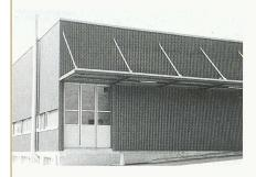
Darwaform-Profilbleche bestehen aus kaltverformtem Stahlblech und sind feuerverzinkt. Dank der Verzinkung ist der Stahlkern beidseitig vor Korrosion geschützt. Der zusätzliche Polyesterlack – erhältlich in umfangreicher Farbpalette – gewährt einen weiteren Schutz gegen Witterungseinflüsse. Die Profilbleche werden für Dacheindeckungen und Fassadenbekleidungen von Industrie- und Gewerbebauten, Unterständen sowie für landwirtschaftliche Betriebsgebäude eingesetzt.
