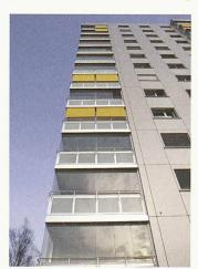
geöffnet werden. Feine Luftschlitze zwischen den einzelnen Glaselementen lassen die Balkone natürlich atmen und verhindern so Feuchtigkeitsschäden. Die Sio AG, Generalvertretung Cover, ist an der Fachmesse Bauen und Modernisieren, Halle 2, Stand B 17, vertreten.
