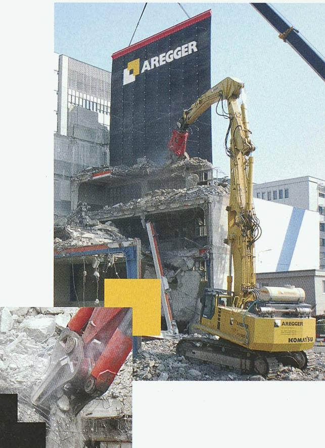
Bis heute war der komplexe Abbruch von Grossobjekten mit Getöse, Staub und Bergen von sperrigen Trümmern verbunden. Das ist jetzt vorbei. Unsere hochmodernen Hydraulikscheren fressen sich scheinbar mühelos und sicher durch jede Stärke und Dimension von Beton und Stahl. Nahezu erschütterungsfrei und mit wenig Lärm, während der schwere Schutzhorn dafür sorgt, dass die Umgebung wirksam geschützt ist.
