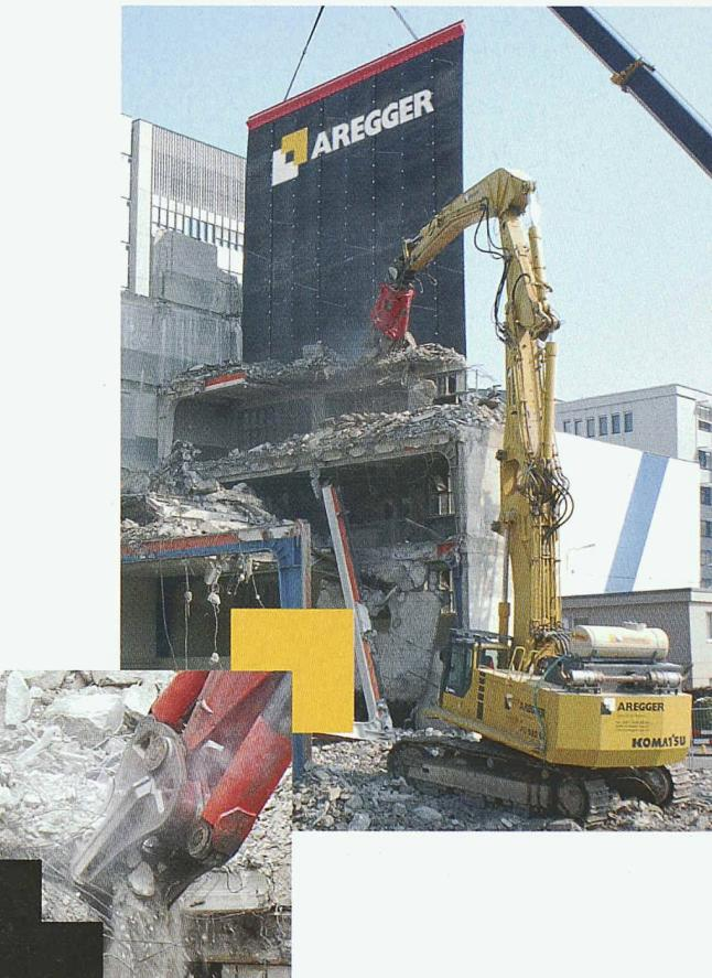
Bis heute war der komplexe Abbruch von Grossobjekten mit Getöse, Staub und Bergen von sperrigen Trümmern verbunden. Das ist jetzt vorbei. Unsere hochmodernen Hydraulikscheren fressen sich scheinbar mühelos und sicher durch jede Stärke und Dimension von Beton und Stahl. Nahezu erschütterungsfrei und mit wenig Lärm, während der schwere Schutzvorhang dafür sorgt, dass die Umgebung wirksam geschützt ist.
