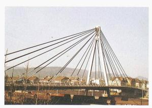
Bei der Storchenbrücke, die den Rangierbahnhof Winterthur überspannt, wurden erstmals versuchweise zwei Schrägseile aus Kohlefasern anstatt aus Stahl eingebaut (Bild: pps)
