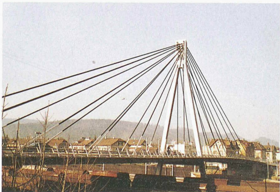
Bei der Storchenbrücke, die den Rangierbahnhof Winterthur überspannt, wurden erstmals versuchsweise zwei Schrägseile aus Kohlefasern anstatt aus Stahl eingebaut (Bild: pps)
