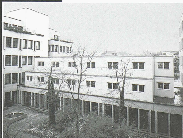
2-geschossiger Aufbau auf bestehendes Flachdach
