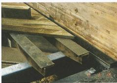
9 Trennschichten, um Feuchteschäden zu verhindern
