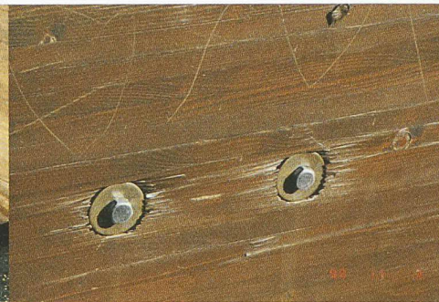
10 Verletzung der Holzoberfläche durch zu starkes Anziehen der Schrauben
