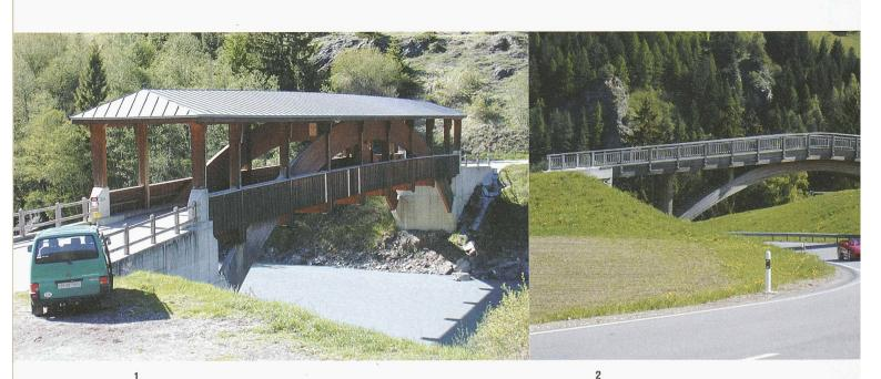
Das Dach bietet einen guten konstruktiven Holzschutz, Ramosch (GR) (Bilder: Empa)
