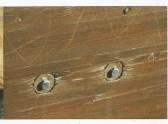
10 Verletzung der Holzoberfläche durch zu starkes Anziehen der Schrauben
