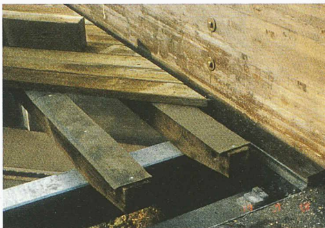
9 Trennschichten, um Feuchte- schäden zu verhindern
