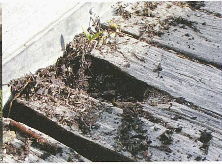
Die zu kleinen Spalten sind mit Erde verstopft – das Holz vermorscht
