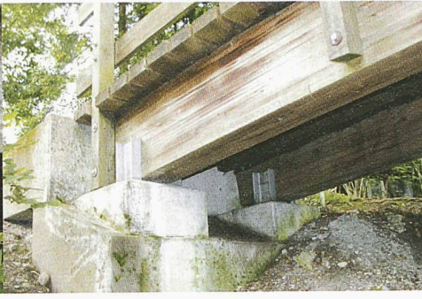
Genügender Abstand zwischen Holz und Boden verhindert die Befeuchtung durch Erde und Pflanzen
