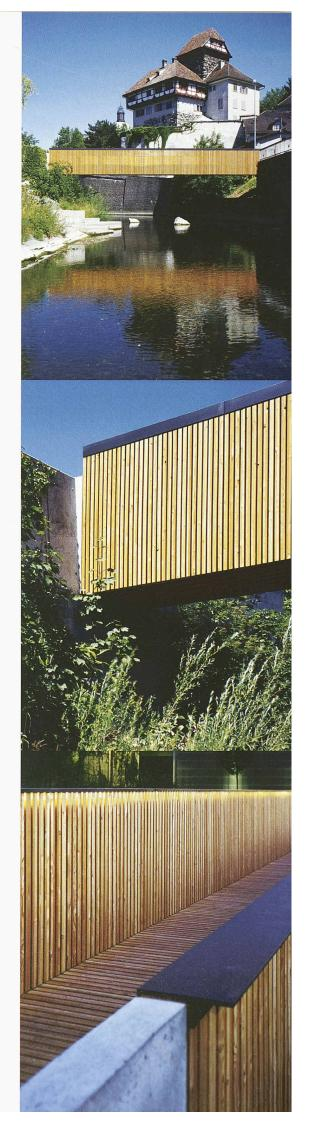
nach aussen geneigten Flussmauer schafft eine vertikale Fläche, an die mit einer kleinen Fuge die Brücke angehängt ist (Bild 2). Das niedrige Geländer führt die Höhe der Ufermauer (die für den Übergang einfach aufgeschnitten wurde) weiter und bindet die Brücke damit am Ufer an. Die von der Baubewilligungsbehörde anfänglich als zu gering kritisierte Höhe der Brüstung (94 cm) konnte nach einer Verbreiterung der Stahlabdeckung des Geländers (Bild 3) beibehalten werden.
