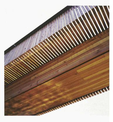
Alles sichtbare Holz an der Untersicht der Brücke ist Lärche (Tragbalken Fichte / Tanne). Unten im Bild die längs laufende Schalung zum Schutz der exzentrisch liegenden Tragbalken. Ganz unten erkennt man in der Fuge die Kante der schwarz eingefärbten seitlichen Duripanelplatten
