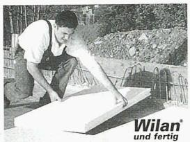
Isolationselemente **einseitig** belegt mit äusserst widerstandsfähigen Fertigdeckschichten aus Kunststoffen, Faserzement oder Holzwerkstoffplatten. Für das direkte Einlegen und einbetonieren in Deckenschalungen oder für nachträgliche Montagen.
