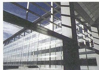
sade des ETH-Erweiterungsbau auf dem Hönggerberg eingesetzt wird. Dank Vorfertigung können auf der Baustelle bis zu 30 m<sup>2</sup> grosse Elemente rationell montiert werden. Die neusten Technologien machen bei Rahmen und Glas eine Verbesserung der Wärmedämmung um 40 Prozent möglich. Für die thermische Sonnenenergienutzung steht ein neuer Flachdachkollektor mit selbstentleerendem Absorber und integrierter Sammelleitung zur Verfügung.
