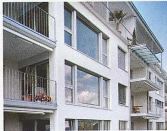
Durch die Kombination verschiedener Glastypen, Rahmenmaterialien und Beschlägen können die unterschiedlichsten Anforderungen bezüglich Wärme-, Schall- und Einbruchschutz realisiert werden. Die Kombination Holz/Aluminium hat in den letzten Jahren
