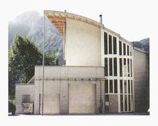
Unübersehbar beim Geschäftshaus Weiss in Mollis sind die grossen Fensterflächen gegen Süden und das konkavkonvex geschwungene Pultdach. Die ganze Gebäudehülle wurde mit Schaumglas wärmegedämmt. Dank der mit Foamglas hoch wärme-
