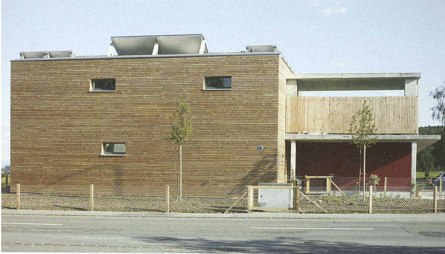
Minergie-P-Haus in Dintikon: Die Nordfassade mit kleinen Fensteröffnungen (Bild: Energie Schweiz, Tom Stocker)
