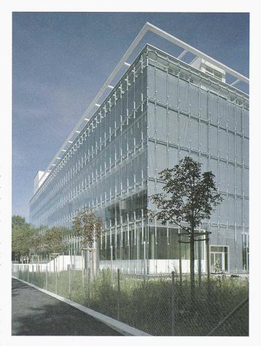
Die Glasfassade ist zweischichtig und unten offen. Klappen am Dachrand regeln Temperatur und Feuchtigkeit
