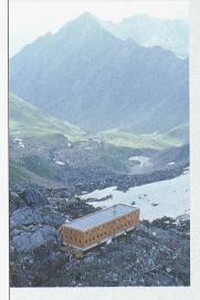
Sarnafil – Kompetenz in Abdichtung Wegen der extremen Lage und des rauhen Klimas mit Windgeschwindigkeiten bis zu 300 km/h und Schneelasten von 2600 kg/m² ist eine spezielle Dachkonstruktion entwickelt worden. Die auf dem Untergrund vollflächig aufgeklebte Dampfbremse, die Wärmedämmung mit integriertem Gefälle, die Kunststoffdichtungsbahn Sarnafil TG 66-20, die speziellen Schutzschichten und die witterungsbeständigen Granitplatten sind Bestandteile dieses Dachsystems.
