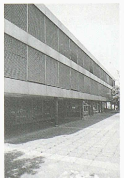
Alt: Fassade ohne Isolation, Einfachverglasung, Baujahr: 1974 (Bild: Architekten)
