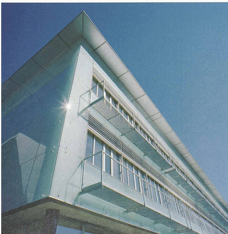
Neu: Glasfassade, Vordach und Reinigungsbalkons (Bild: Markus Beyeler)
