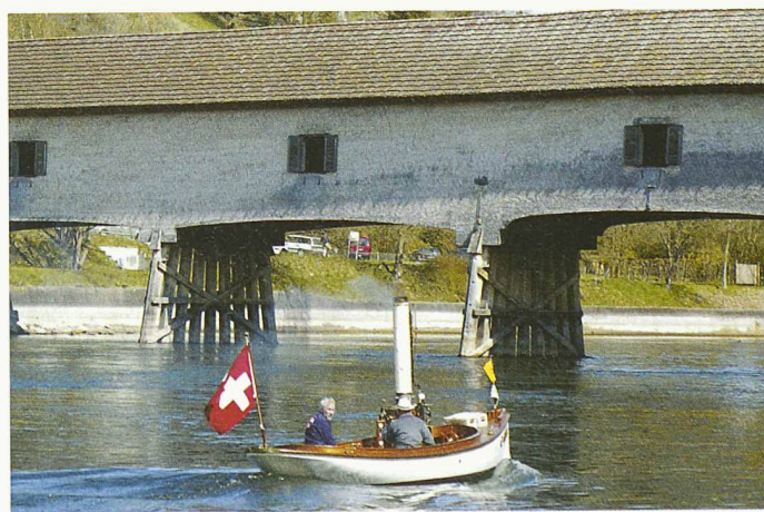
Die gedeckte Holzbrücke über den Rhein zwischen Diessenhofen TG und Gailingen am deutschen Ufer von 1816 ist fertig saniert (Bild: key)
