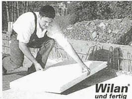
Isolationselemente einseitig belegt mit äußerst widerstandsfähigen Fertigdeckschichten aus Kunststoffen, Faserzement oder Holzwerkstoffplatten. Für das direkte Einlegen und einbetonen in Deckenschalungen oder für nachträgliche Montagen.
