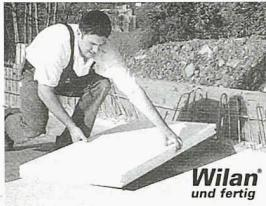
Isolationselemente einseitig belegt mit äußerst widerstandsfähigen Fertigdeckschichten aus Kunststoffen, Faserzement oder Holzwerkstoffplatten. Für das direkte Einlegen und einbetonen in Deckenschalungen oder für nachträgliche Montagen.
