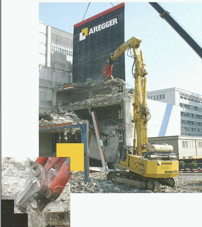
Abbruchobjekte sind meist verblüffend schnell zertrümmt. Die Erde bebt, Lärm und Staub sind infernalisch. Zurück bleibt ein Trümmerfeld, das in Tagen anstrengender und kostspieliger Kleinarbeit sortiert und für den Abtransport portioniert werden muss.
