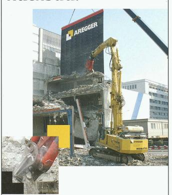
Abbruchobjekte sind meist verblüffend schnell zertrümmert. Die Erde bebt, Lärm und Staub sind infernalisch. Zurück bleibt ein Trümmerfeld, das in Tagen anstrengender und kostspieliger Kleinarbeit sortiert und für den Abtransport portioniert werden muss.
