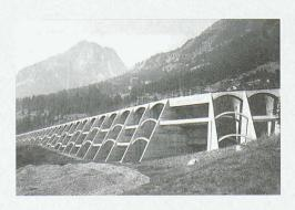
Die Staumauer des Ausgleichsbeckens «Les Marécottes» wurde 1925 in Betrieb genommen. Sarrasin löste mit der Konstruktion als Gewölbereihen-Pfeilerstaumauer mit Bögen einer Dicke von nur 12 cm eine heftige Debatte unter Ingenieuren aus.
