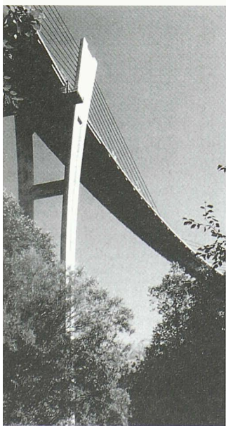
Sunnibergbrücke in Klosters (GR). Die Fahrbahnplatte ist im Grundriss gekrümmt mit einem Radius von 500 m (Bild: Tiefbauamt GR)
