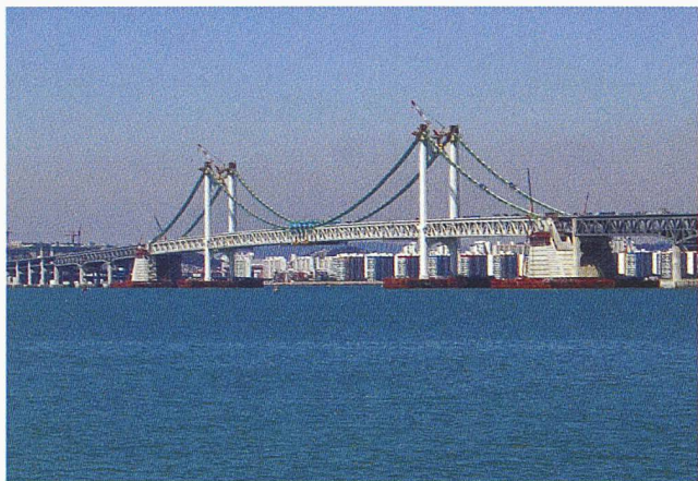
Die Kwang-Ahn-Bridge in Südkorea hat eine Spannweite von 500 m und eine Länge von 5120 m. Der Verkehr rollt auf zwei Ebenen mit insgesamt sechs Fahrspuren. Die grösste installierte Lamellenfuge der Brücke hat eine totale Längsbewegung von 1200 mm und wiegt über 30 Tonnen
