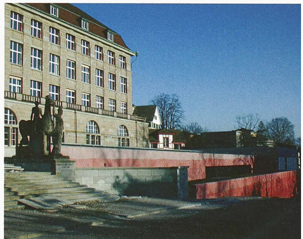
Hommage an den «Vorgänger»: Die roten Stützmauern verweisen auf das Thema der Terrassierung bei Karl Mosers Kollegiengebäude (Bild: Gigon/Guyer)
