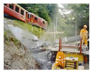
Islisbergtunnel: Voreinschnitt Nord, Geländesicherung mittels Verankerung
