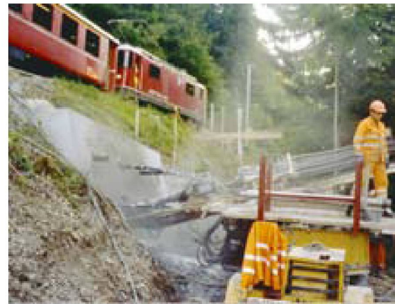
Islisbergtunnel: Voreinschnitt Nord, Geländesicherung mittels Verankerung
