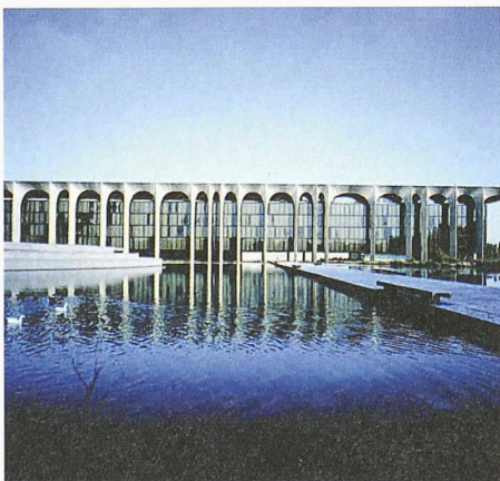
Die rhythmisierte Stützenabfolge charakterisiert die Fassade des Verlagshauses Mondadori in Mailand
