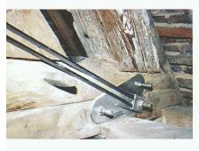
lungsingenieur Andreas Winistörfer liegen die Einsatzgebiete dieser Carbo-Link-Elemente überall dort, wo Zugkräfte effizient mit geringer Masse übertragen werden müssen. Zum Beispiel als Spannglied zur nachträglichen Schubverstärkung von Tragwerken für die Aufnahme von Erdbeben-
