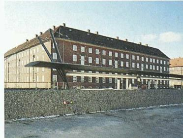
lungsingenieur Andreas Winistorfer liegen die Einsatzgebiete dieser Carbo-Link-Elemente überall dort, wo Zugkräfte effizient mit geringer Masse übertragen werden müssen. Zum Beispiel als Spannglied zur nachträglichen Schubverstärkung von Tragwerken für die Aufnahme von Erdbeben-
