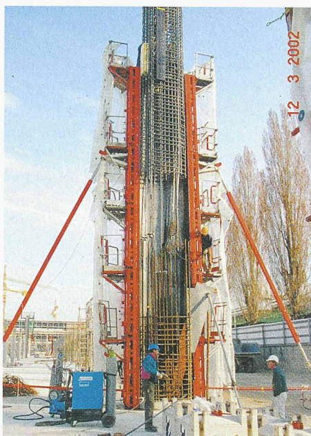
Einschalen eines Pfeilers der Haupttribüne
