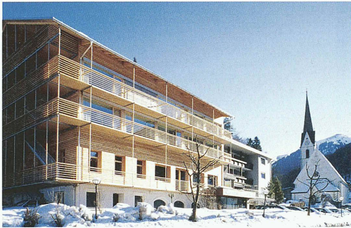
Bauzeit 4 Wochen: Anbau am Hotel Krone in Au/Bregenzerwald mit 20 Betten und einem Seminarraum. In der Zimmerei komplett vorgefertigte Zimmerzellen wurden auf das vorher erstellte Sockelgeschoss gestapelt und montiert (Bild: Ignacio Martinez)
