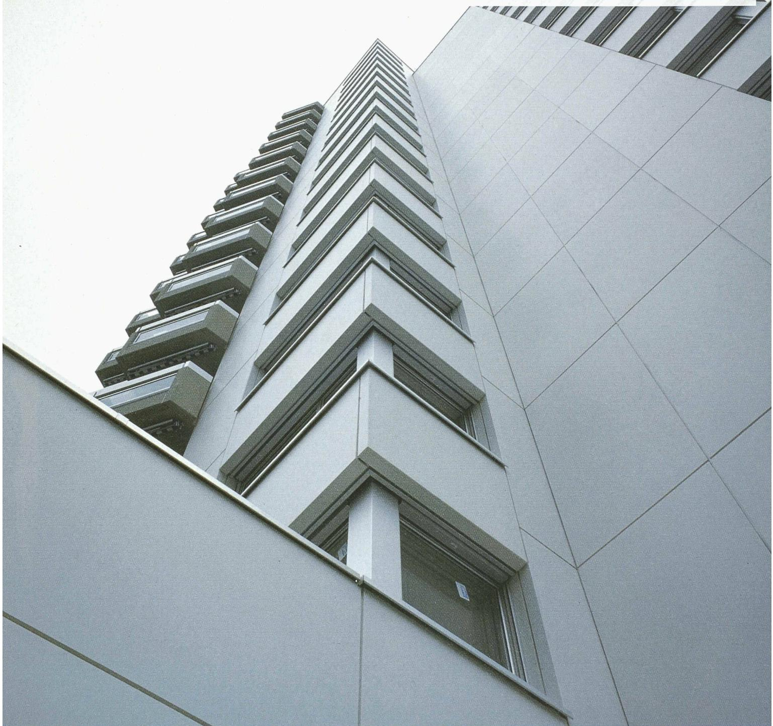
CEMFOR® Fassadenelemente 16mm - Elementgroup MSF
