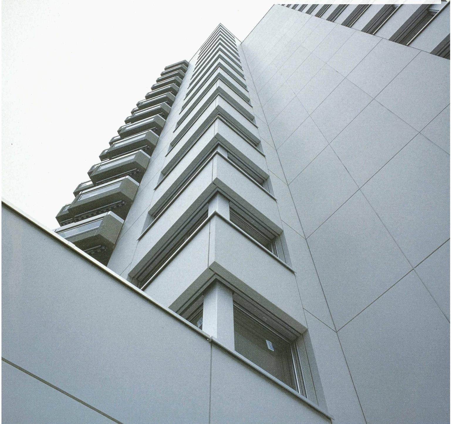
CEMFOR® Fassadenelemente 16mm - Elementgroup MSF
