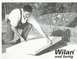
Isolationselemente **einseitig** belegt mit äusserst widerstandsfähigen Fertigdeckenschichten aus Kunststoffen, Faserzement oder Holzwerkstoffplatten. Für das direkte Einlegen und einbetonieren in Deckenschalungen oder für nachträgliche Montagen.
