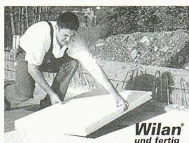
Isolationselemente **einseitig** belegt mit äusserst widerstandsfähigen Fertigdeckenschichten aus Kunststoffen, Faserzement oder Holzwerkstoffplatten. Für das direkte Einlegen und einbetonieren in Deckenschalungen oder für nachträgliche Montagen.
