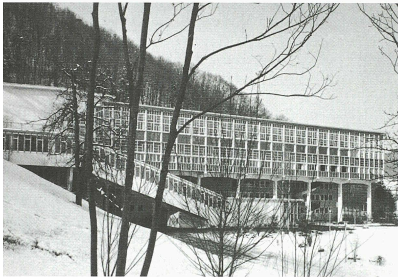
Das 1954 von Armin Meili erbaute ehemalige Wohlfahrtsgebäude «Martinsberg» der BBC in Baden wird zum Berufsbildungszentrum der Stadt Baden umgebaut (Bild: Archiv Meili)
