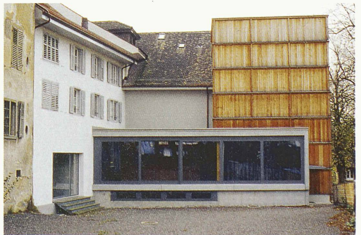
Erweiterung des Stadttheaters von 1925 durch Baumann und Rigling: Das mit Holz verkleidete Bühnenhaus erinnert an frühere hölzerne Anbauten an die Stadtmauer (Bilder: SHS)
