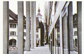
Luigi Snozzis «Stadthof» wirkt als Scharnier zwischen Alt- und Neustadt. Der Bau und seine Funktion als Postbüro werten den Platz auf
