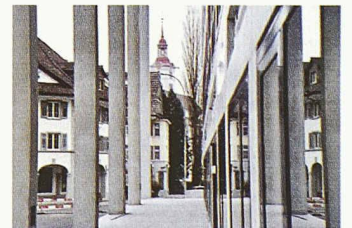
Luigi Snozzis «Stadthof» wirkt als Scharnier zwischen Alt- und Neustadt. Der Bau und seine Funktion als Postbüro werten den Platz auf
