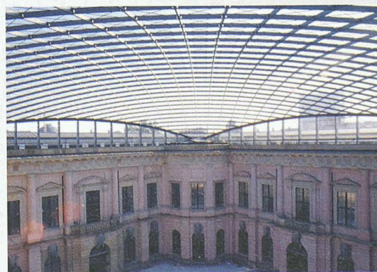
Schlüterhof des ehemaligen Zeughauses in Berlin, heute Deutsches Historisches Museum. Architekten: Pei Cobb Freed & Partners, New York; Tragwerksplanung: Schlaich Bergermann und Partner; 2002
