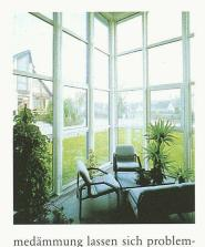
los erfüllen, die PVC-Fenster eignen sich damit auch für die Verwendung in Minergie-Häusern. Der Werkstoff PVC bewirkt eine hohe mechanische Festigkeit und Stabilität der gefertigten Fenster. Fensterprofile aus PVC sind von Natur aus schwer entflammbar. Altfenster werden mechanisch aufgearbeitet, und das zurückgewonnene PVC gelangt wieder in die Fertigung neuer PVC-Profile. Arbeitsgemeinschaft der Schweizerischen PVC-Industrie 5000 Aarau 062 823 07 72 | Fax 062 823 09 72 www.pvch.ch
