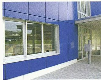
an der Fassade – auf Fassadenplatten und deren Formate abgestimmt – positioniert, dann die werkseitig vorgefertigten Fassadenplatten vor Ort in die Halterkonsole eingehängt. Diese rasche und sichere Montagetechnik basiert auf einem speziellen Einklinkverschluss zwischen Fassadenplatte und Plattenhalter und erlaubt zudem ein bequemes und genaues Justieren.
