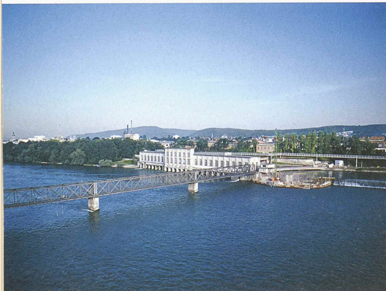
Das Kraftwerk Rheinfelden wurde 1895–98 als erstes grosses Flusskraftwerk Europas gebaut (Bilder: Energiedienst AG)
