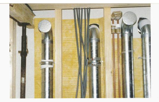
2 Sorgfalt ist gefragt: Bei kleinen Luftleitungen wirken sich Installationsmängel stärker aus als bei grossen Kanälen
