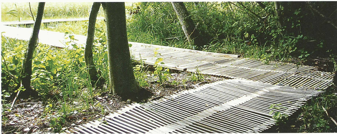
Fussweg durch das Naturreservat Grèves de la Motte bei Portalban am Neuenburgersee. Für den dauerhaften Einsatz (10 bis 20 Jahre) wird Eichenholz verwendet (Bild: M. Wohler)
