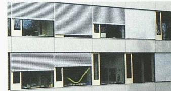
**13 Das Glas trägt mit** | *Daniel Engler* | Mit einer Verzögerung von 20 Jahren im Vergleich zu den Isoliergläsern werden nun auch Fensterrahmen optimiert. Mehrere Hersteller bringen Holzfenster auf den Markt mit teilweise verblüffenden Erfindungen. Oft wird die Glasscheibe jetzt Teil der Fensterstatik.
