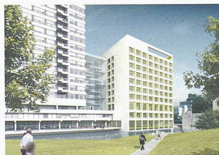
Der neue Turm, verbunden mit dem bestehenden Bettenhochhaus (1. Rang, Metron)
