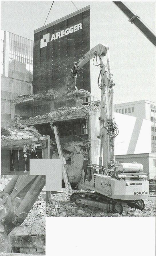
Bis heute war der komplexe Abbruch von Grossobjekten mit Getöse, Staub und Bergen von sperrigen Trümmern verbunden. Das ist jetzt vorbei. Unsere hochmodernen Hydraulikscheren fressen sich scheinbar mühelos und sicher durch jede Stärke und Dimension von Beton und Stahl. Nahezu erschütterungsfrei und mit wenig Lärm, während der schwere Schutzvorhang dafür sorgt, dass die Umgebung wirksam geschützt ist.
