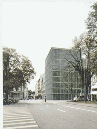
Wettbewerb Picasso-Center, Basel: Siegerprojekt «Baal» von Peter Märkli, Zürich (Bild: Peter Märkli)
