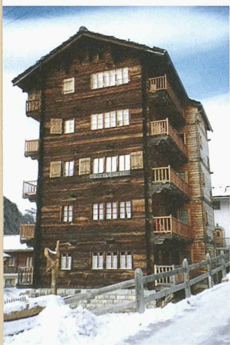
Mehrgeschossiger Holzbau – derzeit dringendster Markterweiterungswunsch der Branche (und mit der neuen Norm ab Mitte 2004 Realität) – wurde bereits vor hundert Jahren praktiziert. Wohnhaus in Evolène, VS (Bild Lignum)
