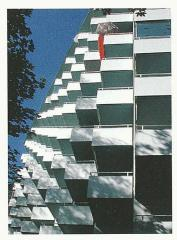
werden im Werk der Eternit AG individuell auf Mass gefertigt und montagebereit geliefert. Innerhalb der verfügbaren Maximal-Nutzformate 2500 × 1220 mm und 2500 × 900 mm sind gewünschte Abmessungen frei wählbar. Das aktuelle und vielfältige Farbangebot umfasst sowohl dezente Pastell- sowie kräftige Akzenttöne. Eine ausführliche technische Dokumentation mit Angaben zu Planung und Ausführung unterstützt anwendungsorientiert bei Entwurf und Realisation.
