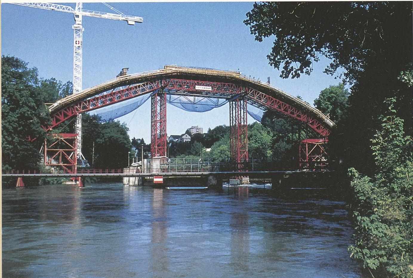
bahnplatte auf dem bereits ausgeschalten Bogen entstehen. Für diese Bauzustände wurde der schlanke Bogen unter den beiden äusseren Bogenstützen provisorisch gestützt (Bild 4). Für die Bemessung der Bogenbewehrung waren die Bauzustände für den Brückenüberbau massgebend, und die Bogenträgfähigkeit bestimmte Anzahl und Reihenfolge der Betonieretappen des Überbaus.
