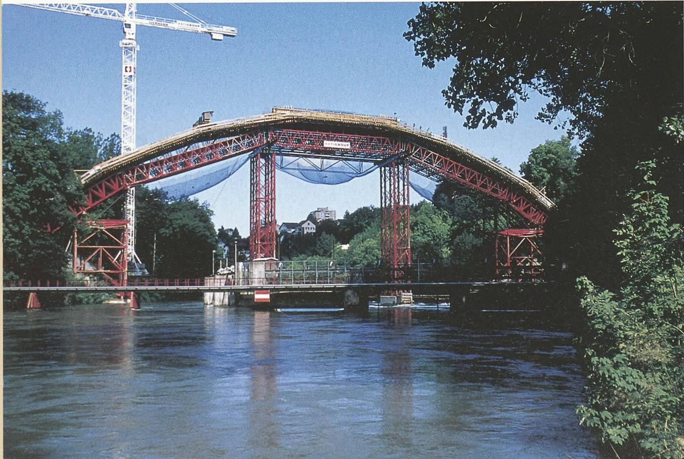
bahnplatte auf dem bereits ausgeschalteten Bogen entstehen. Für diese Bauzustände wurde der schlanke Bogen unter den beiden äusseren Bogenstützen provisorisch gestützt (Bild 4). Für die Bemessung der Bogenbewehrung waren die Bauzustände für den Brückenüberbau massgebend, und die Bogenträgfähigkeit bestimmte Anzahl und Reihenfolge der Betonieretappen des Überbaus.
