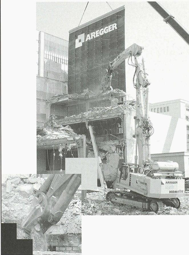
Bis heute war der komplexe Abbruch von Grossobjekten mit Getöse, Staub und Bergen von sperrigen Trümmern verbunden. Das ist jetzt vorbei. Unsere hochmodernen Hydraulikscheren fressen sich scheinbar mühelos und sicher durch jede Stärke und Dimension von Beton und Stahl. Nahezu erschütterungsfrei und mit wenig Lärm, während der schwere Schutzhang dafür sorgt, dass die Umgebung wirksam geschützt ist.
