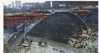
**14 Statisch-dynamische Belastungsversuche** | *Gottfried Egger* | Unmittelbar vor der Eröffnung wurde die fertig gestellte Siggenthalerbrücke durch die Empa Dübendorf umfangreichen Belastungsprüfungen mittels Lastwagen unterzogen. Die Ergebnisse zeigen eine gute Übereinstimmung zwischen den theoretischen Voraussagen und dem realen Bauwerksverhalten.
