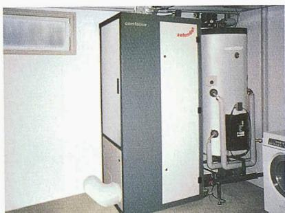
Betriebsbereite, wartungsarme Kompakteinheit comfobox für das MINERGIE Einfamilienhaus mit Sole-/Wasser-Wärmepumpe mit Kühlungsfunktion
