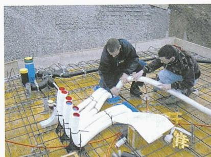
Einfach verlegbares, flexibles Lüftungssystem comfofresh mit wenigen Komponenten
